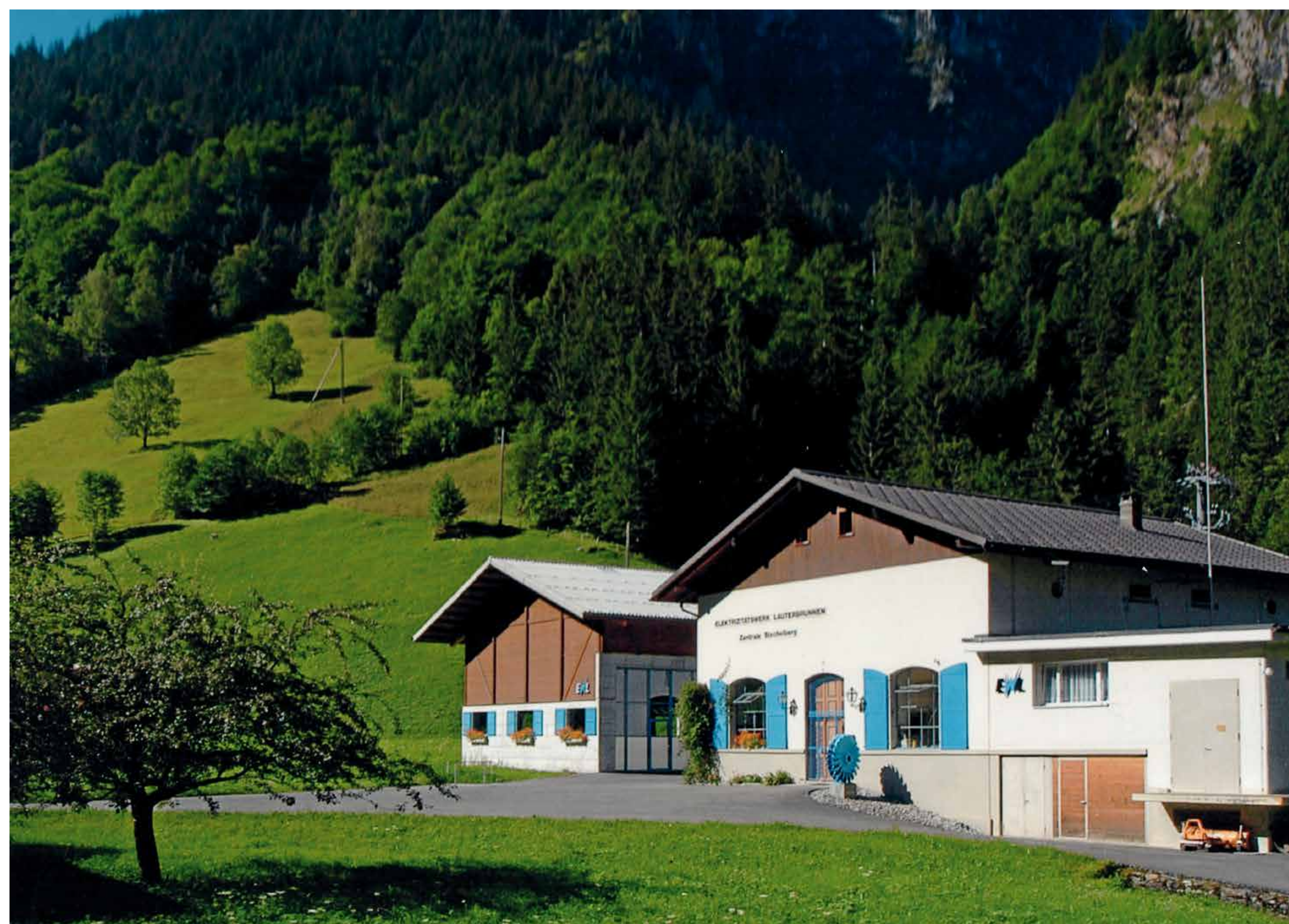
Zentrale Stechelberg, 2006 (Foto: Wasserkraftwerk Stechelberg)
